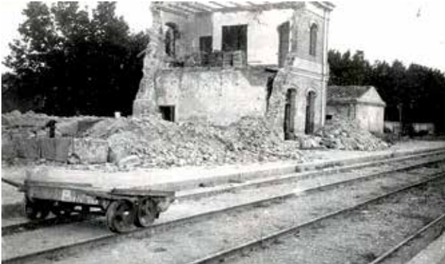
L'estació de l'Arboç després del bombardeig. (Foto: Arxiu Arbocenc)
